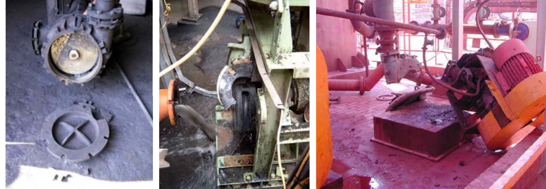
ALCUNE IMMAGINI DI POMPE CENTRIFUGHE CHE HANNO SUBITO FENOMENI ESPLOSIVI
