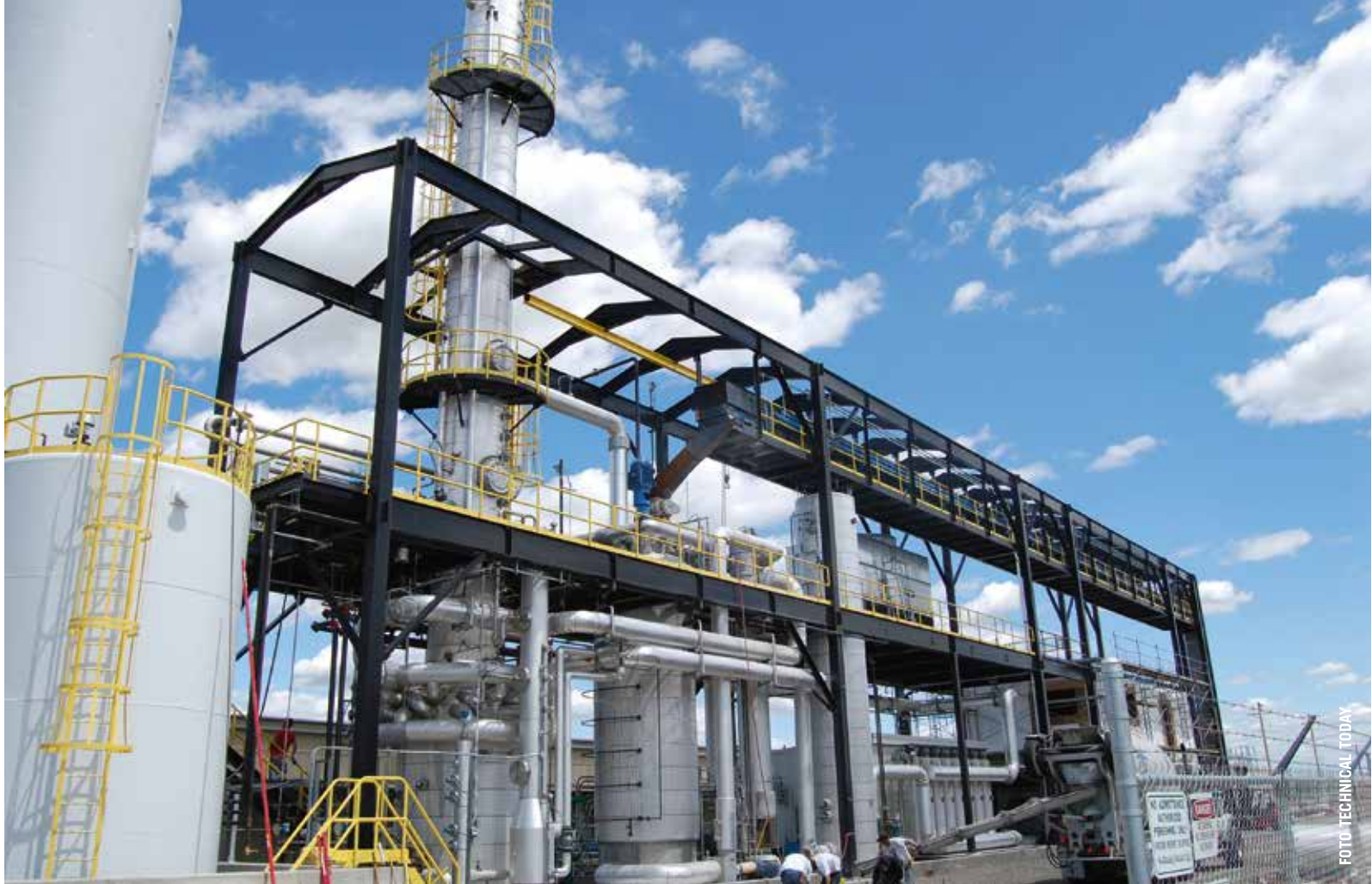
UN IMPIANTO “WASTE-TO-ENERGY”
