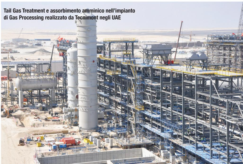
**Tail Gas Treatment e assorbimento amminico nell'impianto di Gas Processing realizzato da Tecnimont negli UAE**
