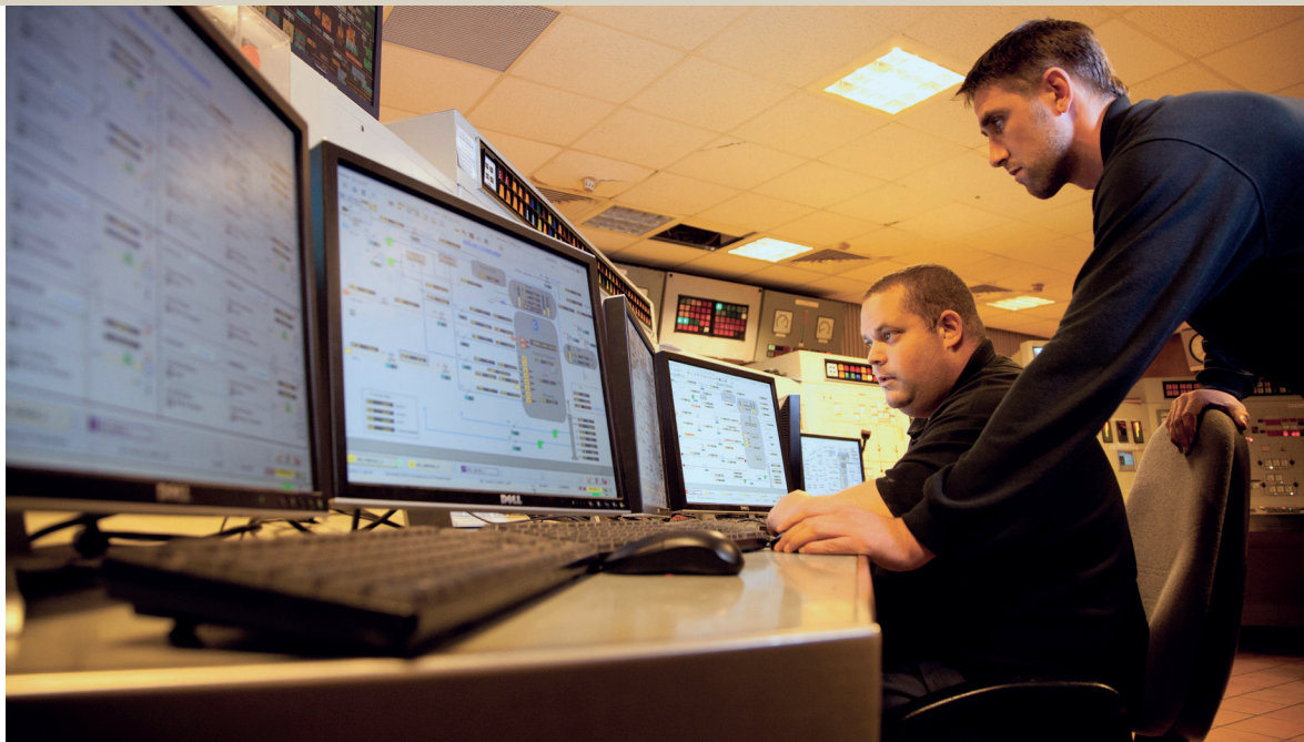
Control room di un impianto Tata Steel Impianto Combined Cycle Gas Turbine Foto Emerson Process Management
